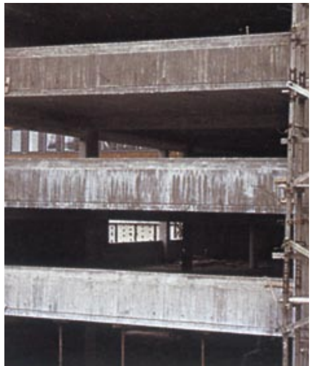
Ausblühungen durch Betonguss in der kalten, regnerischen Jahreszeit.
