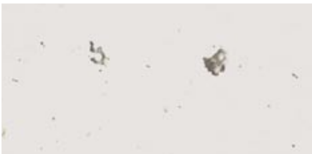
Beispiel für Porenbildung durch die falsche Vorbehandlung des Schalungs-materials
