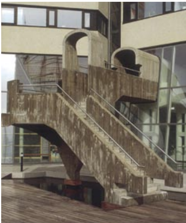
Farbiger Beton mit farbiger Ausblühung.
