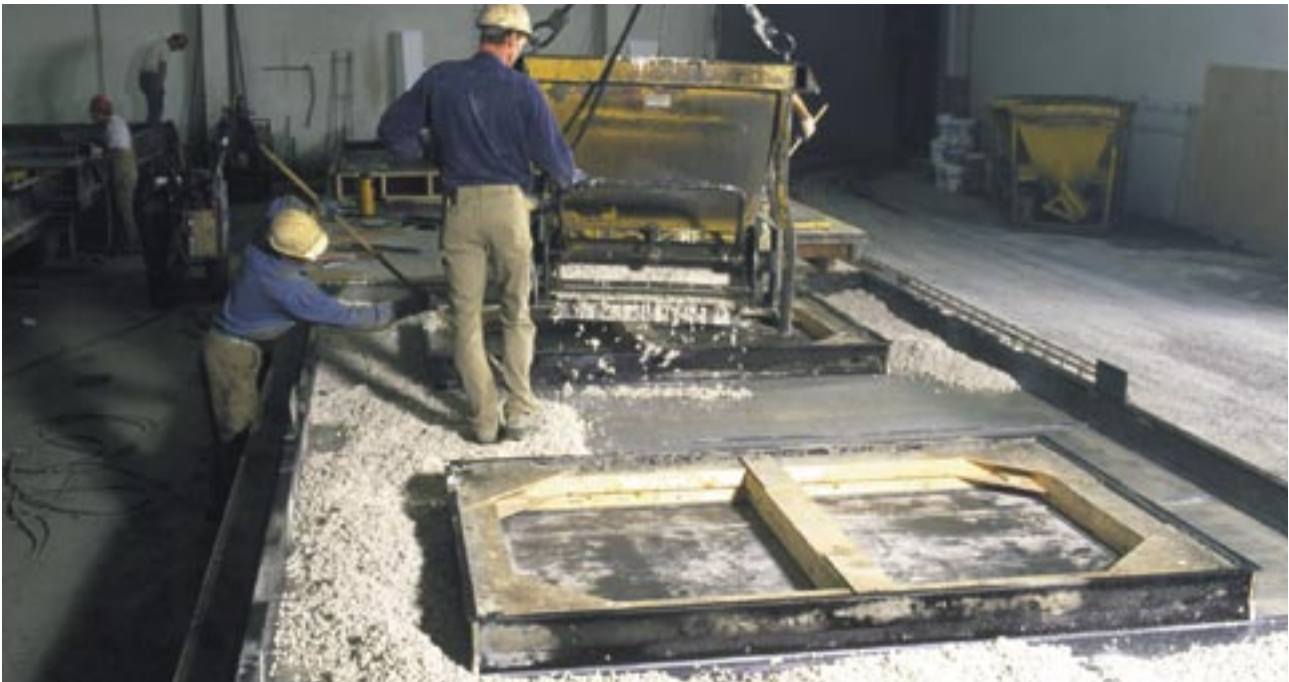
Rütteltisch für sichtbare Betonelemente.
