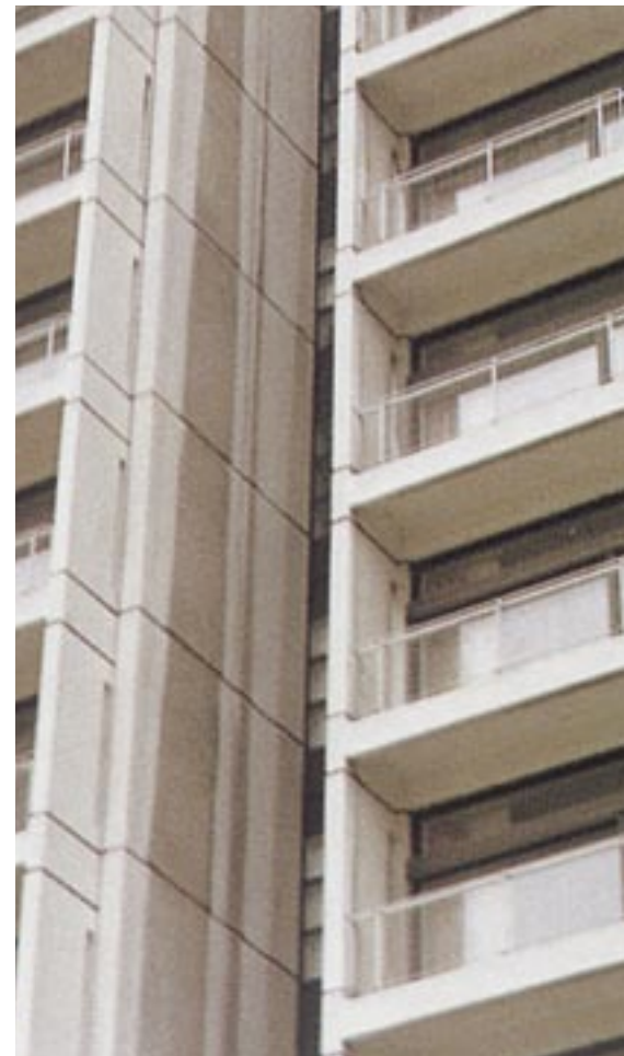
Schmutz auf einem Giebel, der von einem Nachbargiebel beschattet wird.
